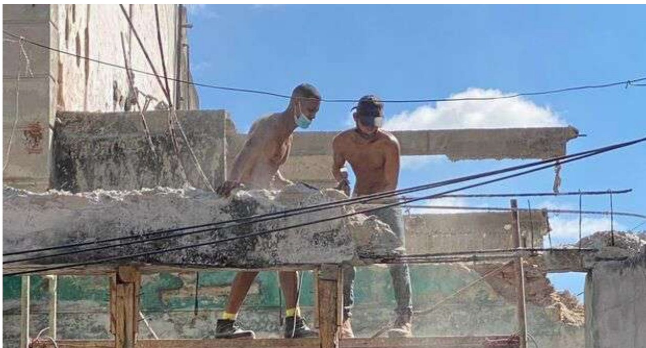
Subidos a un andamio, los jóvenes taladran con el martillo neumático los viejos arquitebras que han quedado de la esquina de Monte y Ángeles. (14ymedio)
